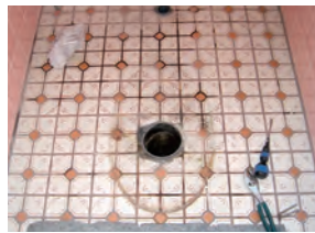
6 既設の床フランジを外します ※下記「床フランジの取外し方」を参照
