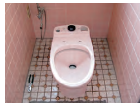
8 便器本体を設置します
