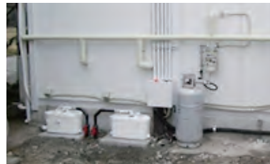
圧送ポンプ設置(工事中) ※工事後カバー設置
