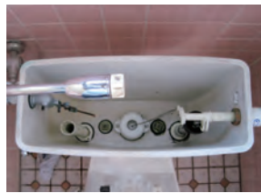
3 ロータンク内の水を抜きます
