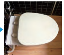
簡易水洗トイレ
