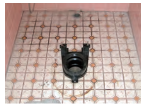
7 新しい床フランジを取付けます
