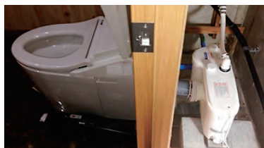
便器の後ろに圧送ポンプを設置し、メンテナンススペースを設けました。
