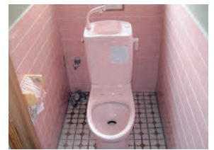
10 ロータンクを取付けます
