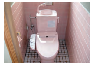
11 便座を取付け完成
