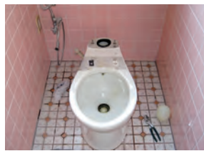
4 ロータンクを外します
