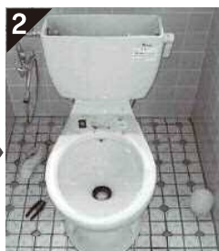
2 便座とタンクフタを外してください。 ロータングの水を抜いてください。
