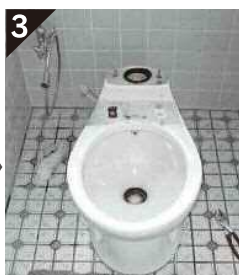
3 給水管を外し、ロータングを外してください。 プラスチック製のロータングは 取り外さなくても作業できます。
