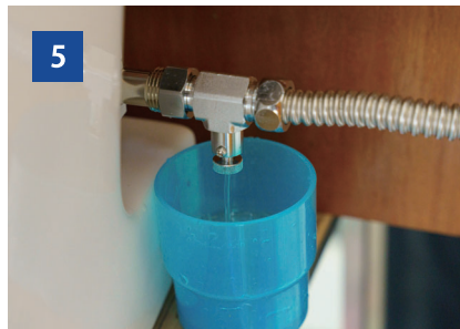
完全に水が抜けたことを確認してください。約1分かかります。
