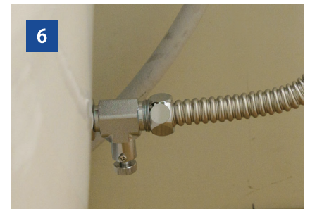
水抜き栓を閉める。
