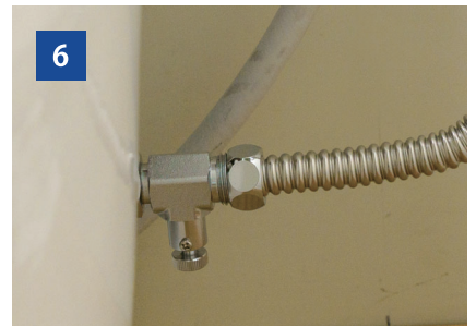
6 水抜き栓を閉める。
