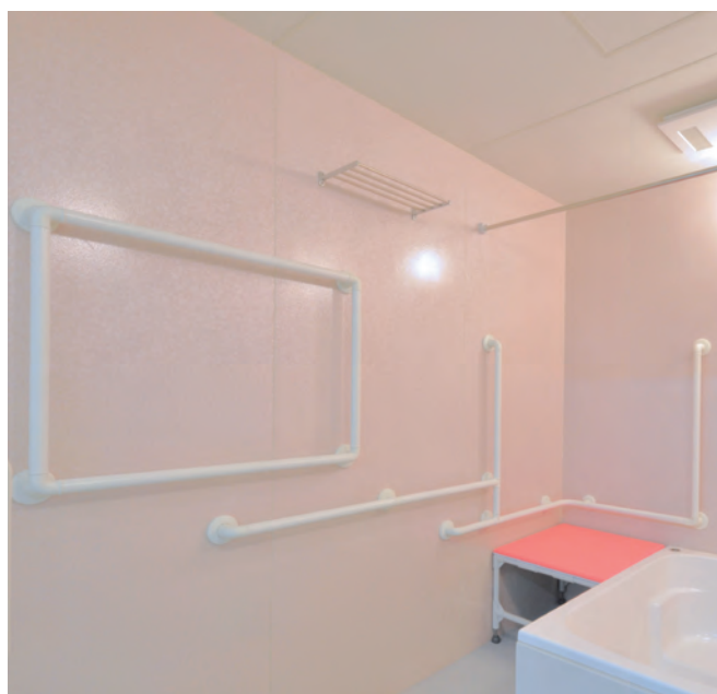
連続手すりを配置
