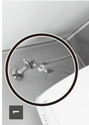
止水栓を閉める。
