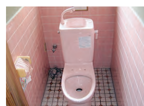
10 ロータンクを取付けます
