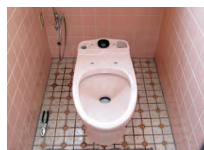
8 便器本体を設置します
