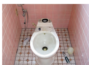
4 ロータンクを外します
