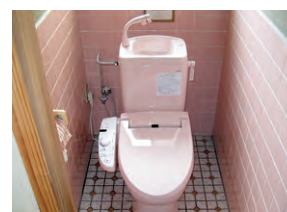
11 便座を取付け完成
