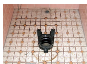
7 新しい床フランジを取付けます
