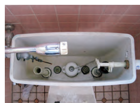
3 ロータンク内の水を抜きます
