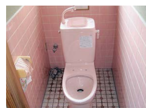
10 ロータンクを取付けます
