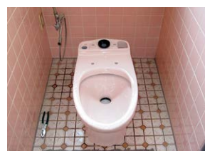
8 便器本体を設置します
