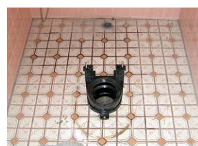
7 新しい床フランジを取付けます
