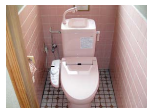
11 便座を取付け完成
