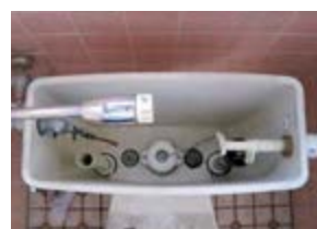
3 ロータンク内の水を抜きます
