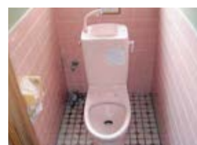
10 ロータンクを取付けます
