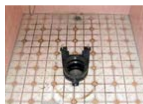
7 新しい床フランジを取付けます
