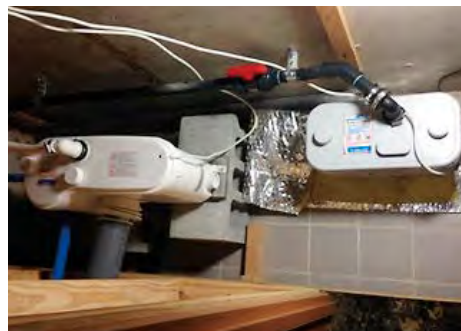
トイレ用圧送ポンプ(左)と雑排水用圧送ポンプ(右)
