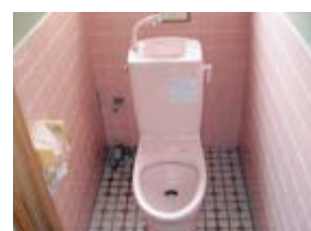
10 ロータンクを取付けます
