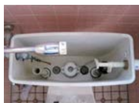
3 ロータンク内の水を抜きます
