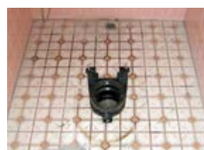
7 新しい床フランジを取付けます
